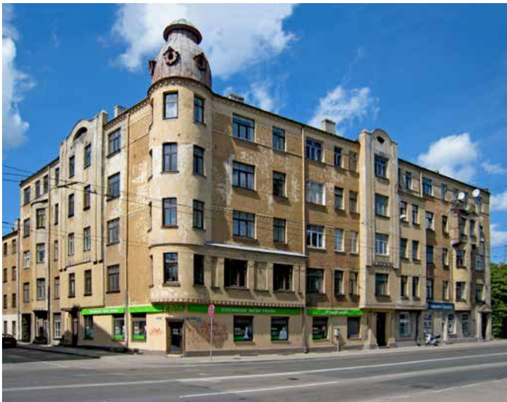
15. att. Īres nams ar veikaliem Rīgā, Lāčplēša ielā 112. 1911. Fasādes projekts un kopskats. A. Vanags, P. Kampe
